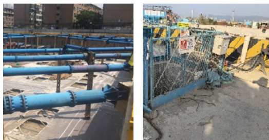
► 基坑工程现场
